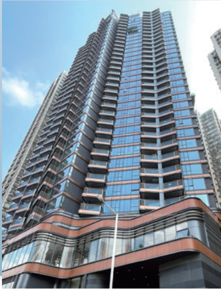
Composite development at No. 11 Ngau Tau Kok Road, Kowloon 九龍牛頭角道11號之綜合發展項目
